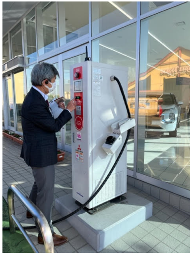
図 13 自動車ディーラーでの急速充電器
