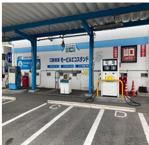
図7 EV 充電設備
