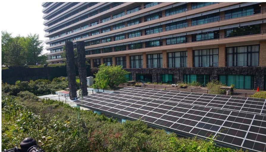
図9 熊本県庁の太陽光パネル
