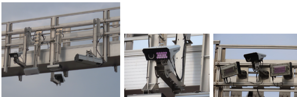
DSRC アンテナとナンバー読み取りカメラ と 車線全体撮影(軸数検知)カメラ
