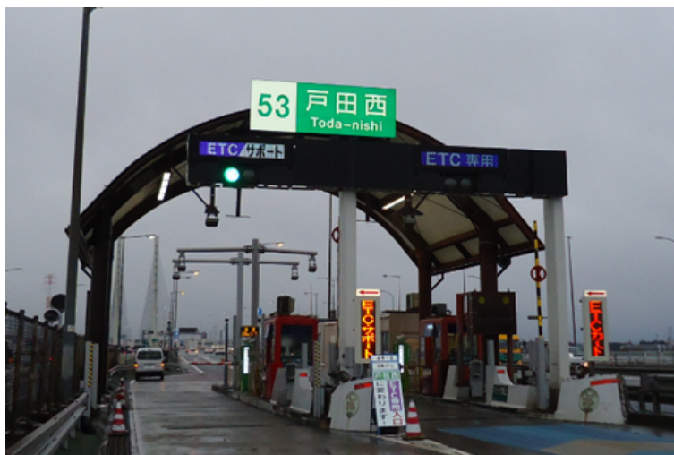
図 5.1.4 戸田西料金所専用化導入後の料金所写真
