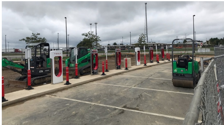
図 6.2.11 高速道路に充電器を設置中
