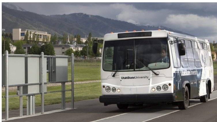
図 6.2.18 電気道路の例（非接触型）
