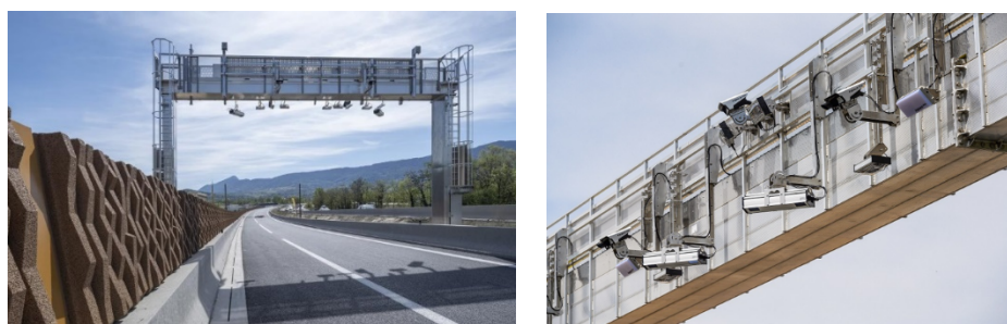
図 2.2.2 運用開始したフリーフローETC(左)とガントリーに設置された機器(右)
