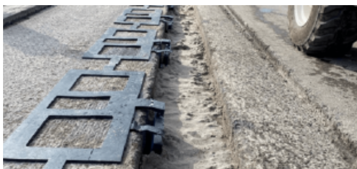
図 6. 2. 25 誘導充電用コイル群が舗装面に埋め込まれる
