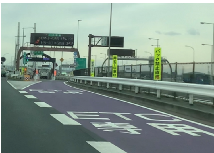
図 5.1.5 入口部専用化の路面標示と標識
