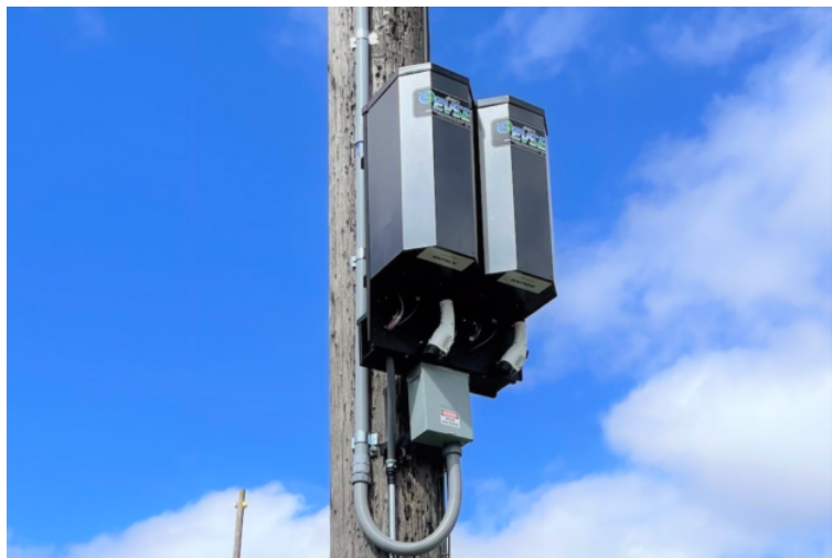
図 6.2.5 電柱に設置されたレベル 2 の EV 充電器（シアトルシティライト経由の写真）
