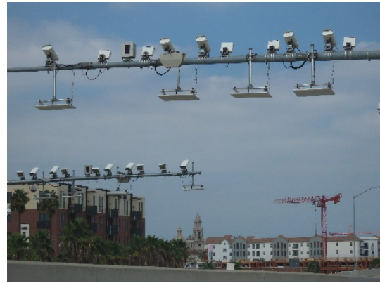
路側機器 (車載器通信とカメラ撮影)
