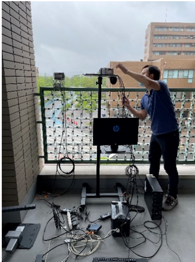
図 4.5 機器設置場面
