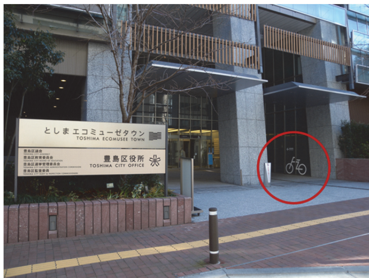
図 4.20 建築物と一体的な駐輪場
