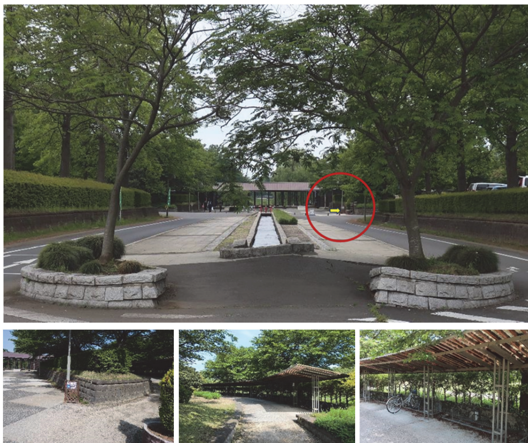
図 4.21 道路公園施設と一体的な駐輪場
