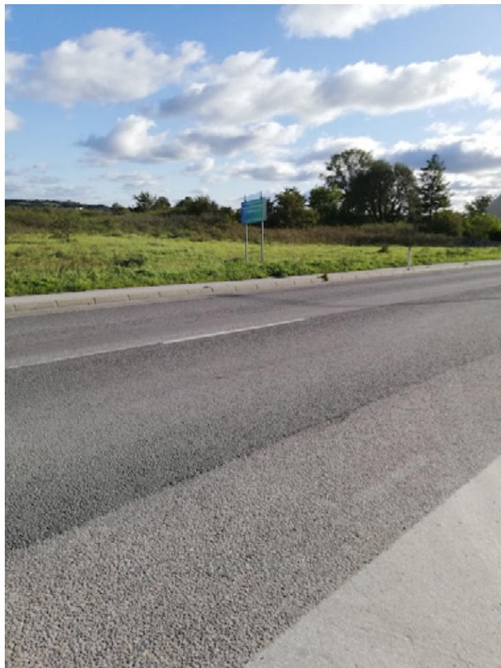
図 3.2 ゴットランド島の対象道路（舗装下に給電設備が埋め込まれている）
