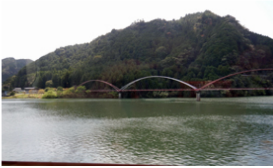
写真 2.1 鉄道未成の佐久間線の船明ダム 上流に架かる通称「夢のかけはし」 (整備後自転車道となる。2023. 3. 28)
