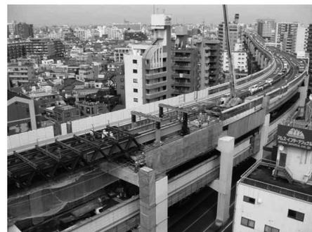
迅速な復旧工事、橋桁架設状況
