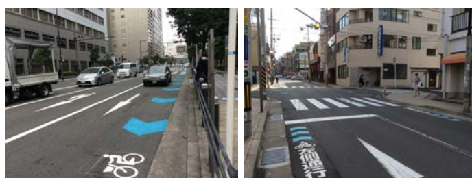
（大阪市） （鹿児島市） 車道上の通行位置、方向を示した路面表示の事例
