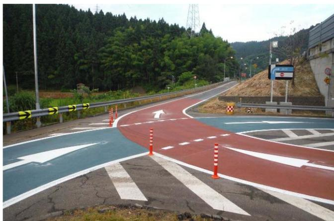
平面Y型ICの交差点部の対策
