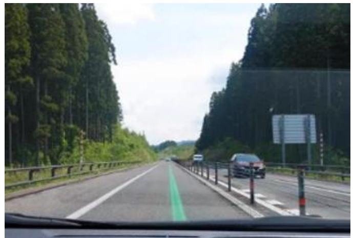
試行的に車両誘導線を設置
