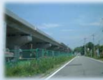
道路橋梁の維持管理
